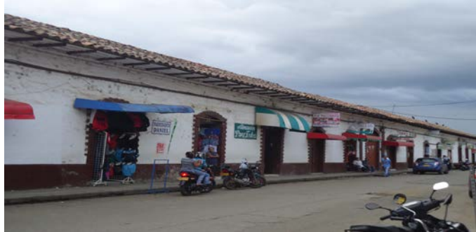
Plaza de mercado en su parte exterior.
