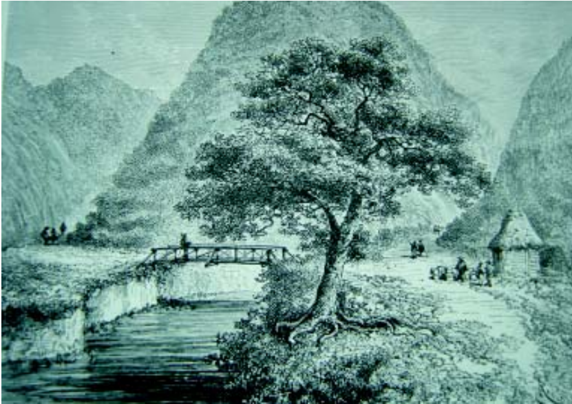
Figura 9. Vista de Juntas.
