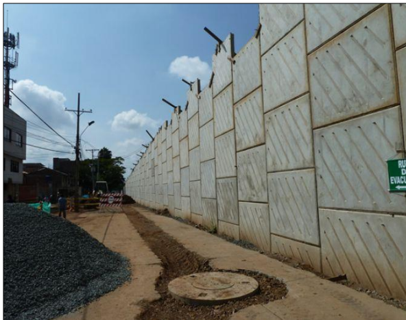
Ilustración 1: Muro en tierra armada para puente vehicular en la ciudad de Cali. Fuente: Empresa Stup Latinoamérica.
