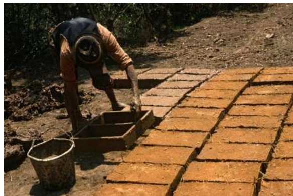
Gráfica 3. Proceso constructivo en tierra
