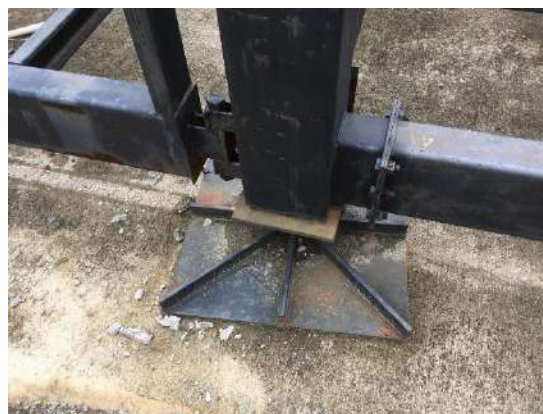
Gráfica 39. Placa base metálica de cimentación
