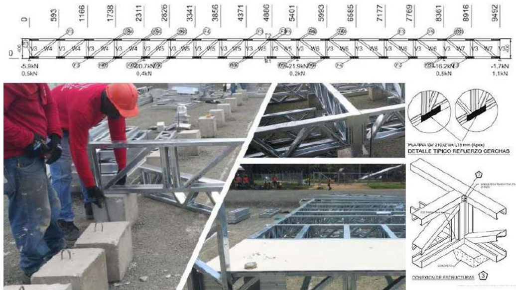
Gráfica 28. Proceso de armado de viguetas
