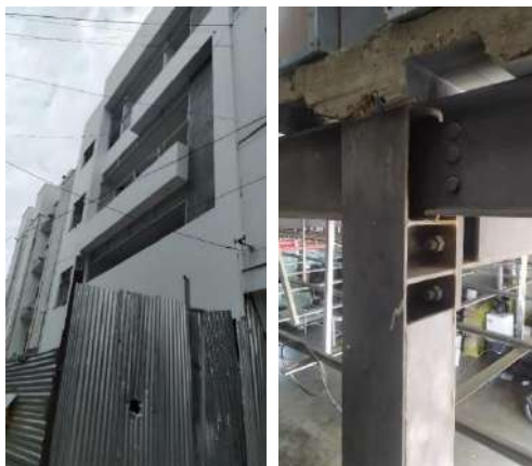
Gráfica 13. Edificio San Rafael Cali en estructura metálica
