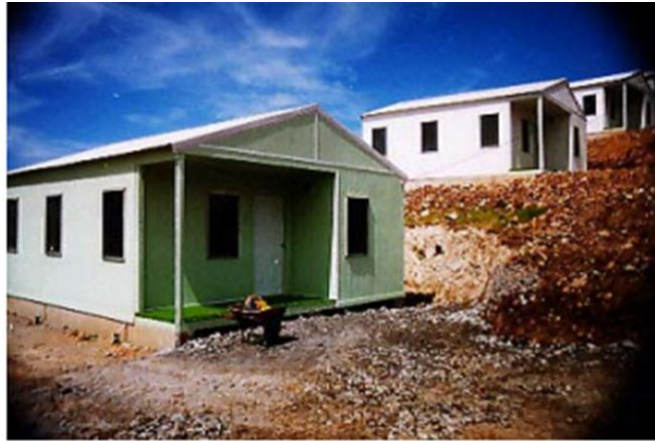
Figura 2. Vivienda prefabricada en Montserrat. Fuente: Fox, 2002
