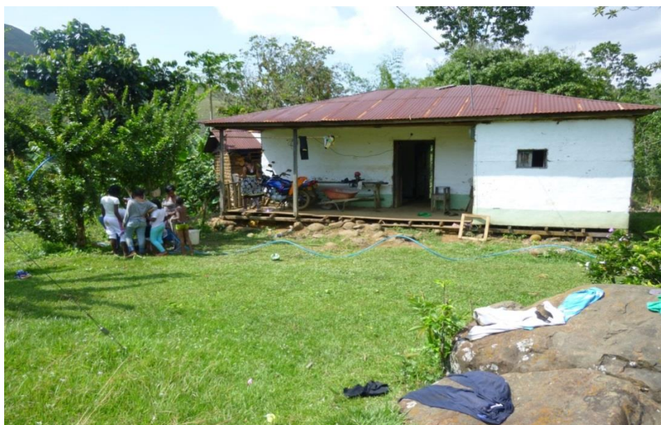
Fotografía 2. Condición de viviendas
