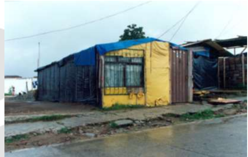
Imagen 9. Refugio después del terremoto de Armenia, Colombia, 1999.
