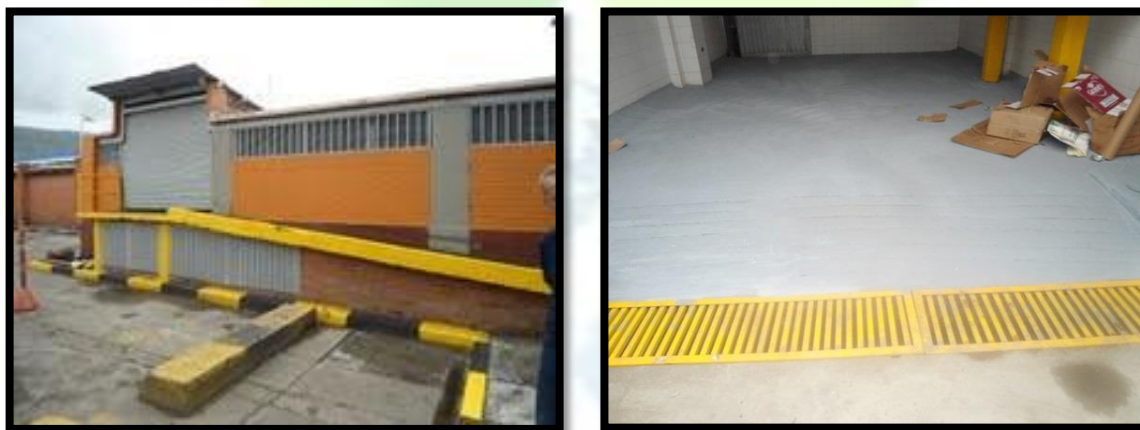
Ilustración 7 unidad técnica de almacenamiento (exterior e interior)
