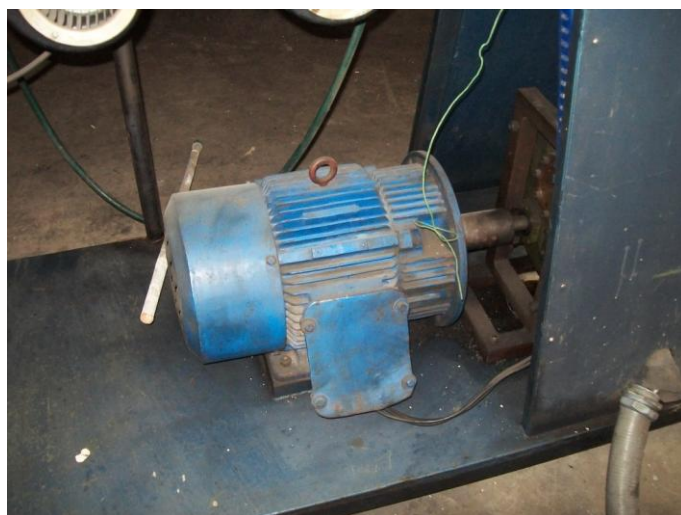
FOTO 2. ENSAMBLE DEL REDUCTOR Y DEL MOTOR
