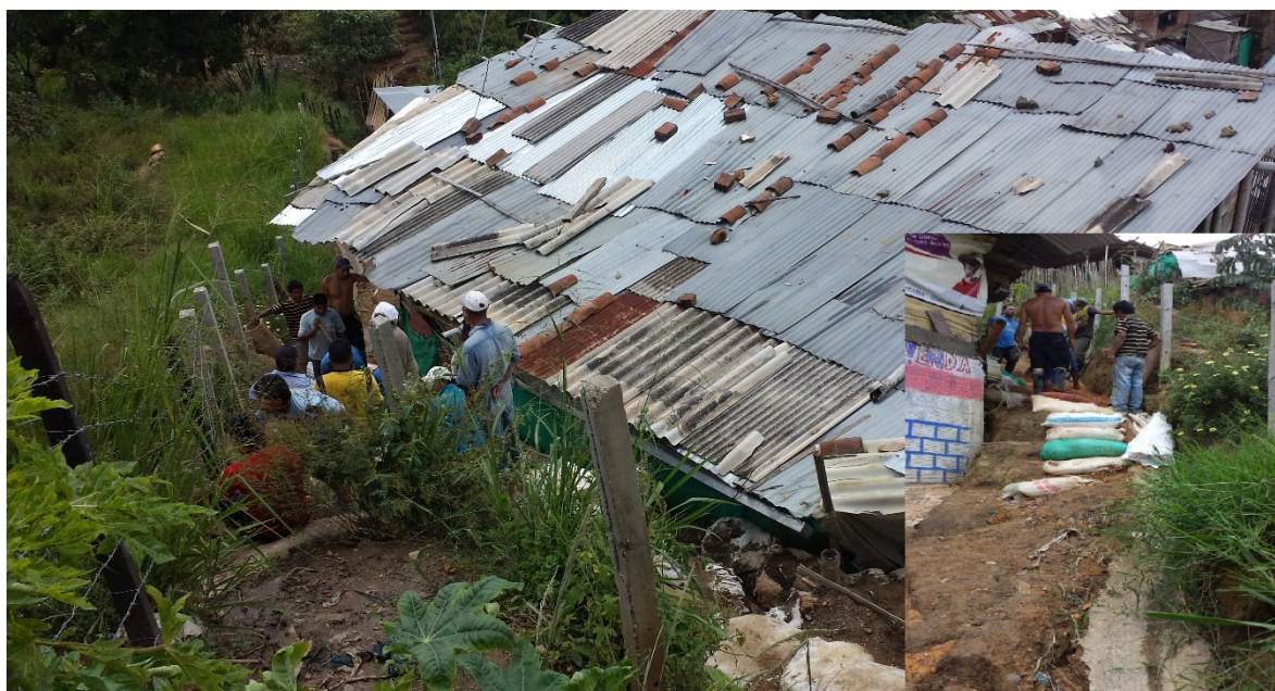
Foto 12. Construcción de mitigación sector SA1
