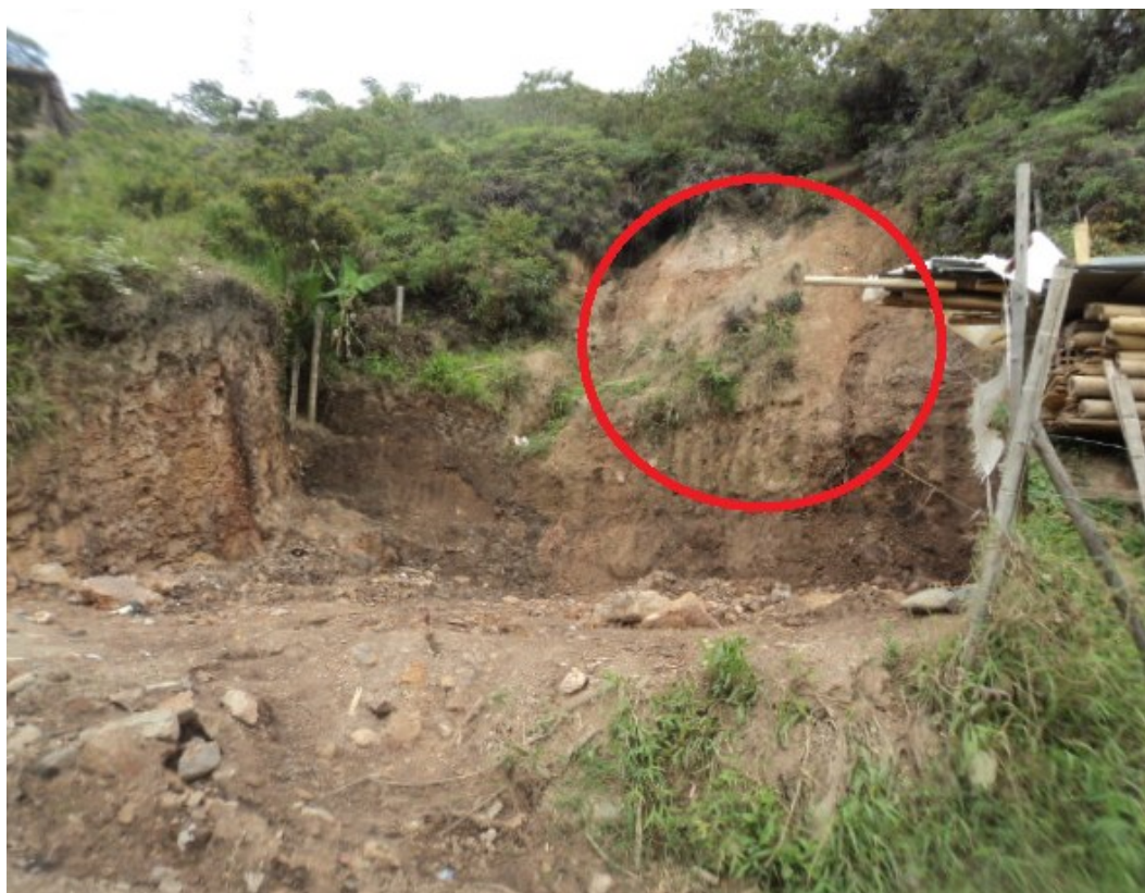
Foto 6. Deslizamientos antiguos (círculo rojo) aprovechados para construcción de viviendas.
