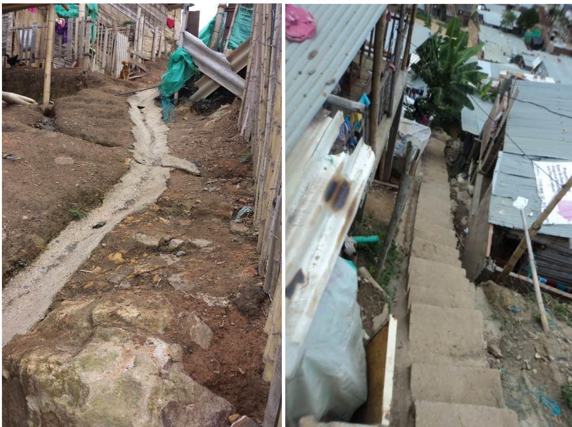
Foto 13. Obras de mitigación sector SA1
