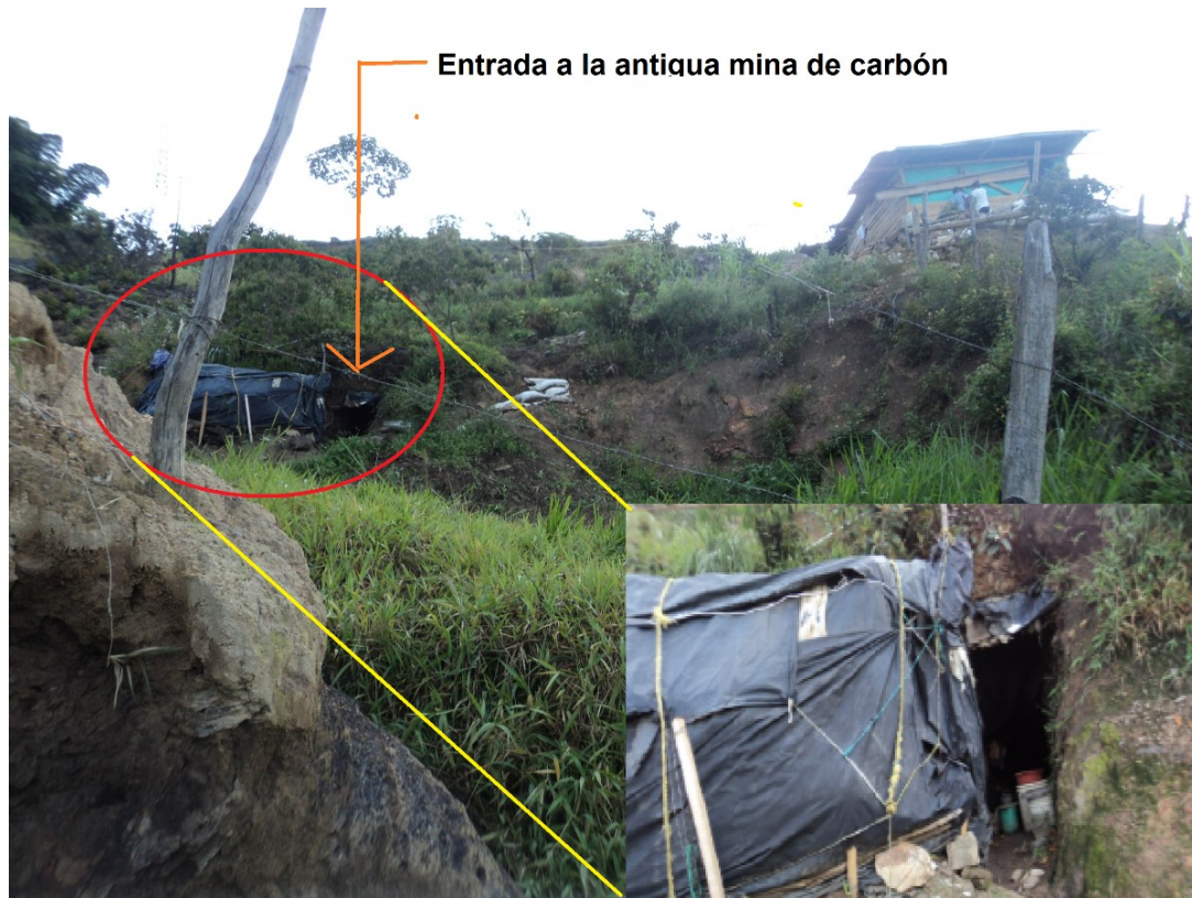
Foto 7. Viviendas sobre la antigua mina de carbón
