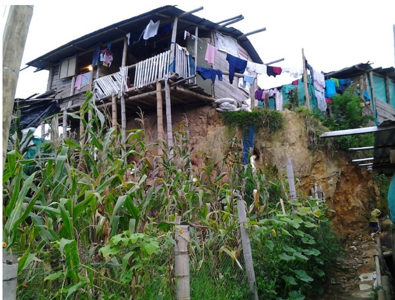
Foto 3. Viviendas soportadas sobre pilotes
