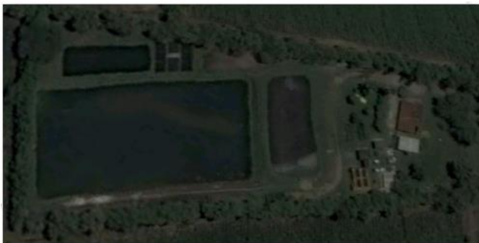
Figura 4. Vista aérea de la PTAR de Ginebra Valle.
