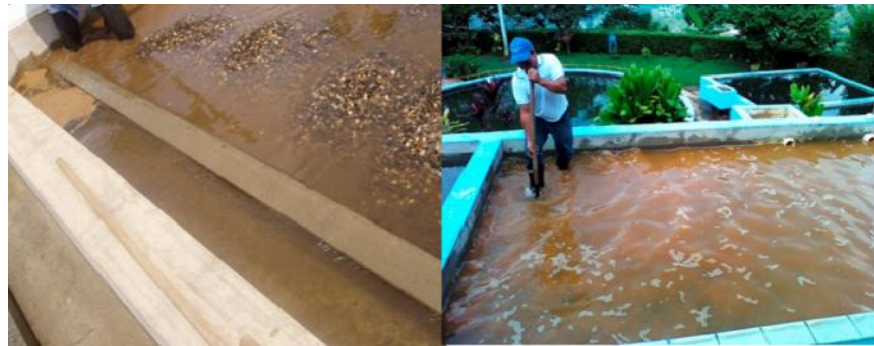
Canaletas (izquierda) y orificios (derecha) de salida de agua
