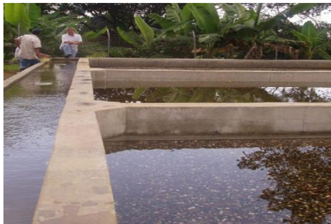
Figura 4 Unidades FGAC Planta Retiro
