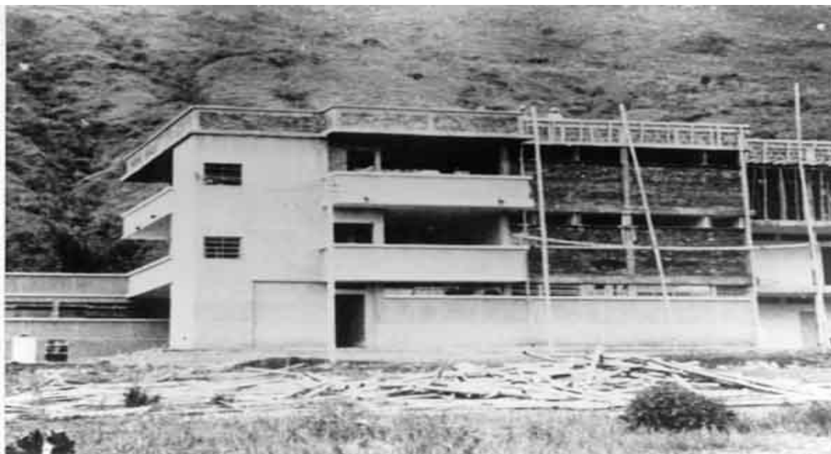
Construcción del Colegio Mayor de Yumbo en 1959. (Mayor 1983, 215)
