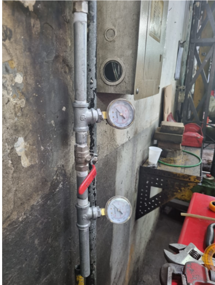
Figura 5.9: Medición de la resistencia al flujo
