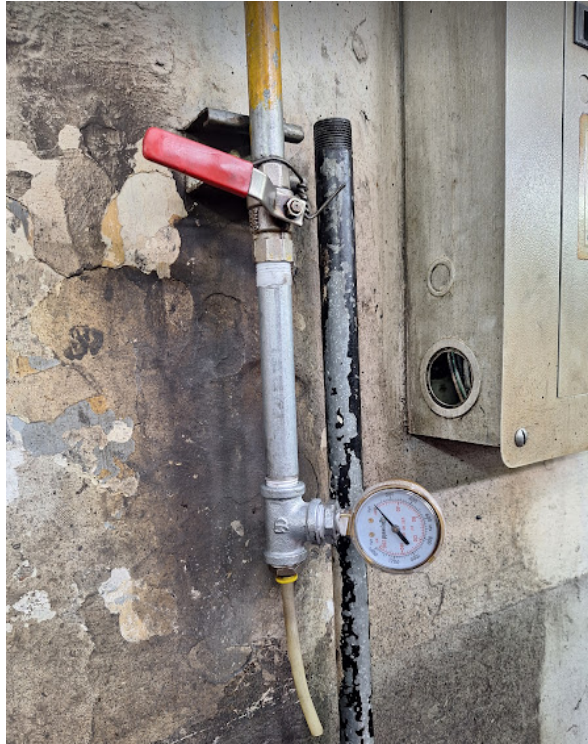
Figura 5.8: Medición de la presión de operación
