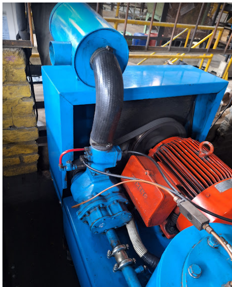
Figura 5.1: Compresor de tornillo de la empresa
