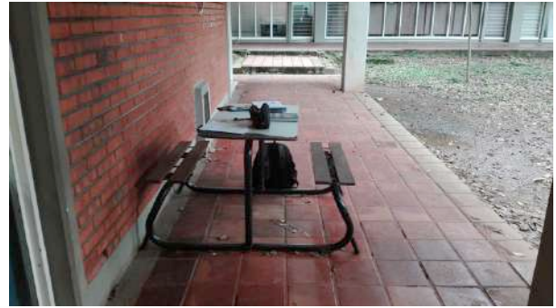
Imagen 29. Alcatraces metálicos con madera en corredores externos bajo techo. Fuente propia.
