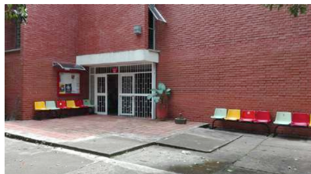
Imagen 15. Entrada Edificio 382, Diseño, asientos dispuestos en la plazoleta de transición. Fuente propia.
