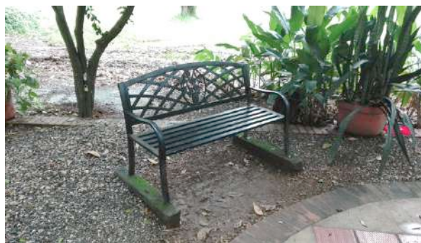
Imagen 35. Banca metálica con espaldar fija al suelo mediante fundición de concreto. Fuente propia.
