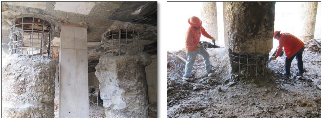
Imagen 12. Demolición de anillos en sótano.
