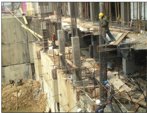
Imagen 16. Construcción columnas y losa en eje A.
