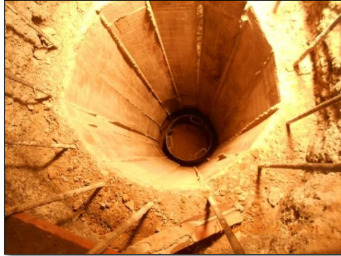
Imagen 5. Primer tramo de anillos para caisson
