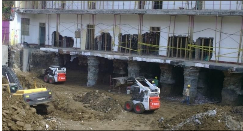
Imagen 10. Excavación de sótano.
