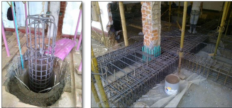
Imagen 7. Refuerzo para caisson y cabezal superior.
