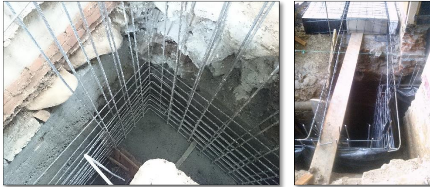
Imagen 6. Muro de contención esquina ejes 7-C y 1-B.
