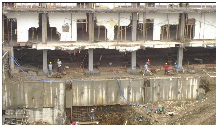
Imagen 14. Fachada interna Edificio 1.
