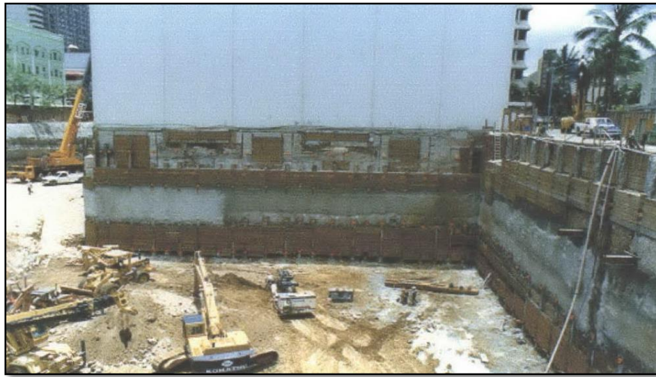
Imagen 1. Vista General de trabajos de excavación, Honolulu.
