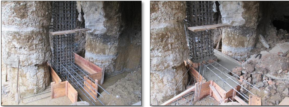
Imagen 11. Armado y fundición de cabezales inferiores.
