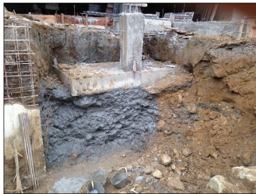
Imagen 15. Zapata eje A (sin confinamiento).
