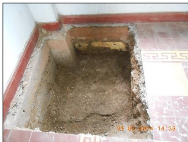
Imagen 2. Exploración de cimentación existente.
