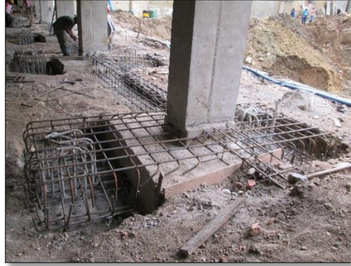
Imagen 13. Complemento refuerzo de cabezal inferior.
