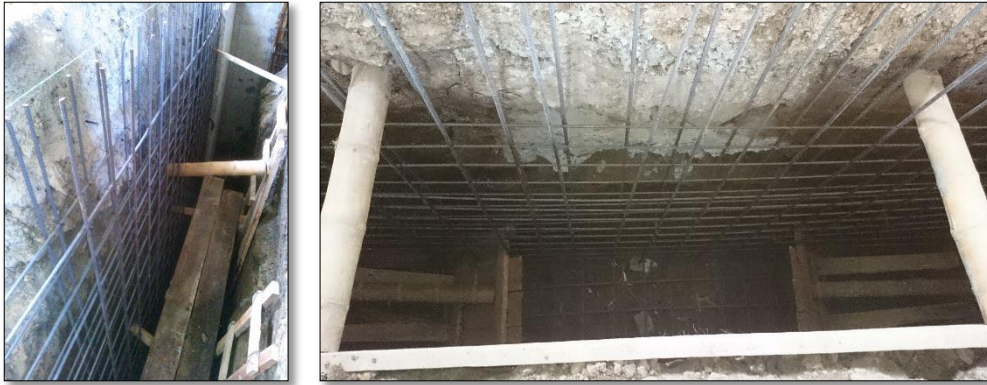
Imagen 4. Refuerzo para muro de contención
