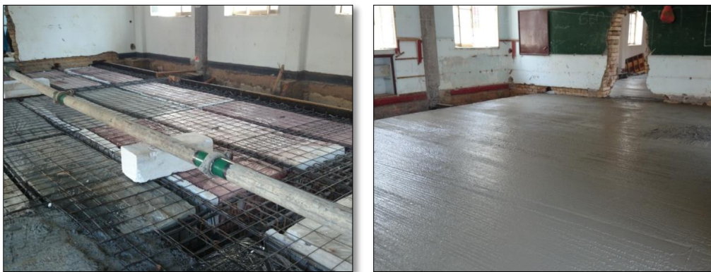
Imagen 8. Armado y fundición de losa de primer piso.
