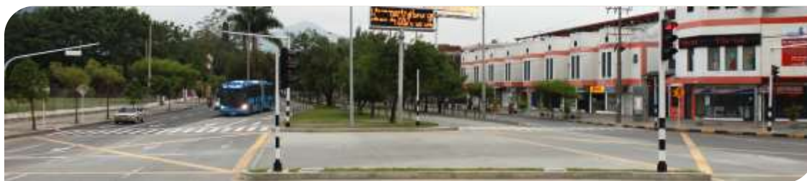
Foto 8. Paso peatonal calle 5 carrera 50.
