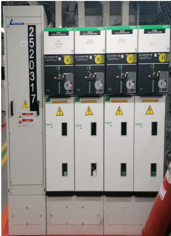
Figura 22. Tren de celdas en SF6 Torre A, Torre C y Centro del cáncer
