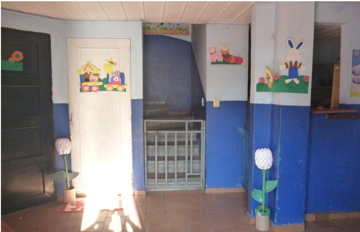
Figura20. Zona común del colegio antes de remodelación
