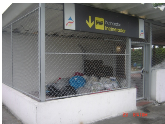
Ilustración 1: Zona de almacenaje temporal de los residuos incinerables
