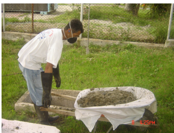
Ilustración 5: Recolección y disposición de lodos obtenidos de los desarenadores, cajas de inspección y del tanque separador de grasas.
