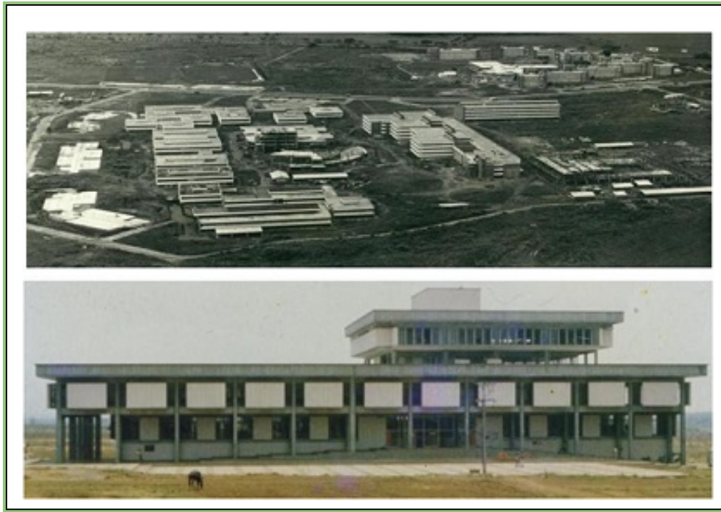
Imagen 1. Construcción de los edificios de la Facultad de Ingeniería y del edificio de la Biblioteca Mario Carvajal.
