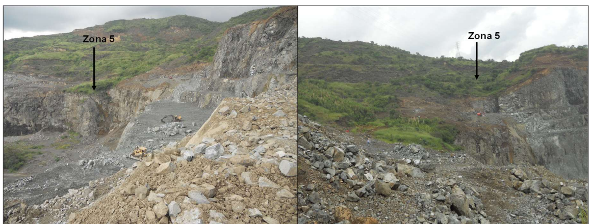
Fotografía 13. Aspecto general de la Zona 5.
