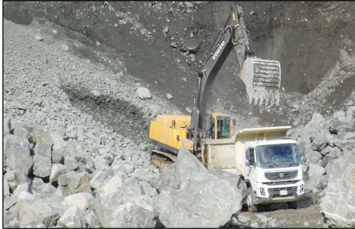
Figura 18. Cargue de Material.
