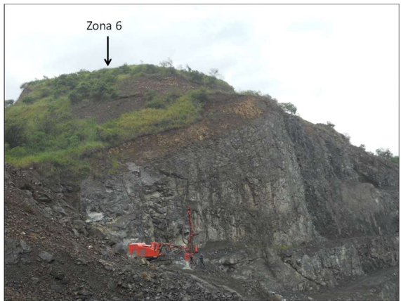
Fotografía 14. Aspecto general de la Zona 6.
