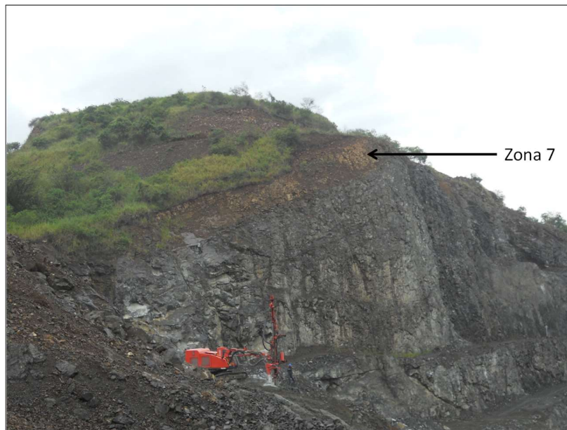
Fotografía 15. Aspecto general de la Zona 7.
