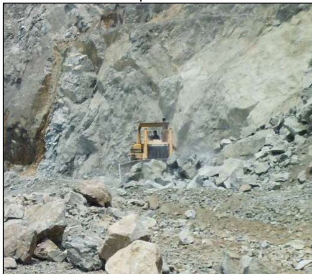
Figura 17. Desabombe con Buldócer.
