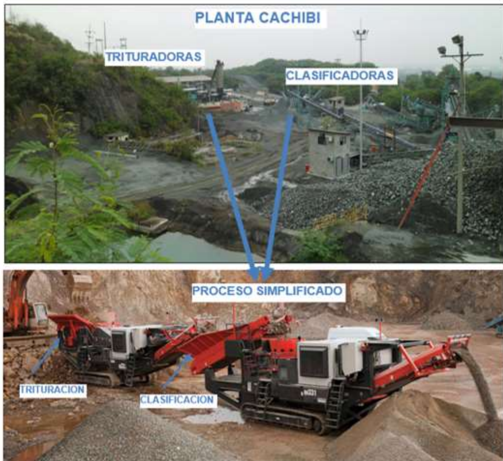
Figura 3. Proceso de trituración y clasificación en la planta de agregados.
