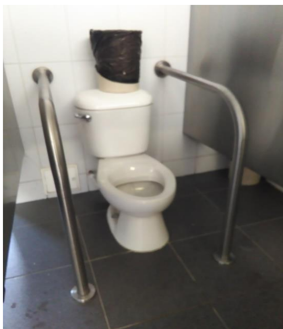
Figura 5. Mobiliario interno (Sanitario en el baño de niñas)
