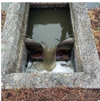
Figura 19. Vertedero de 90 ° – Salida laguna anaerobia
