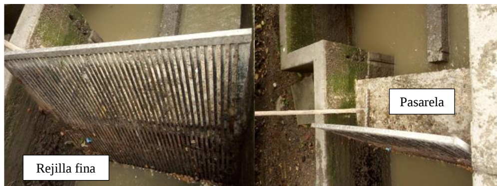
Figura 11. Rejilla fina – entrada desarenador.
