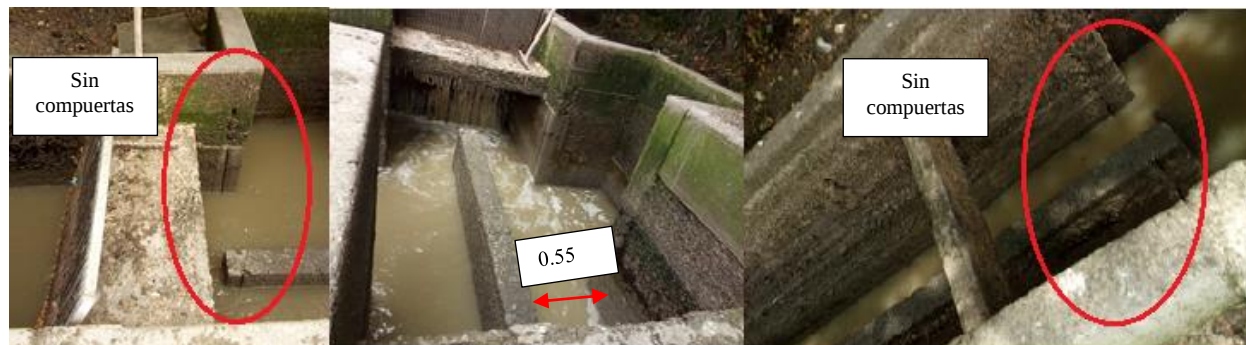
Figura 13. Desarenador
