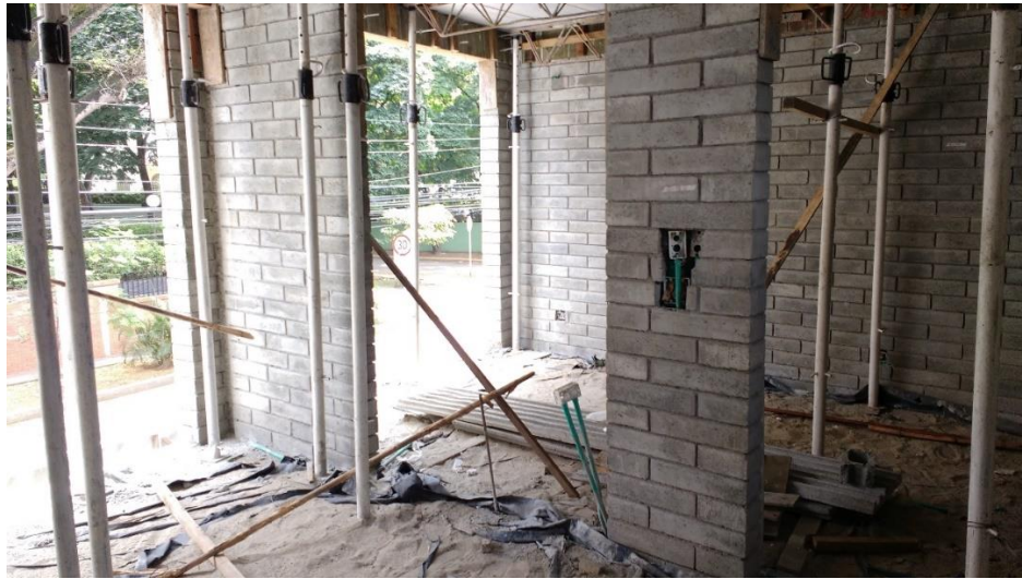
Ilustración 22. Apartamento de Macondo en construcción.
