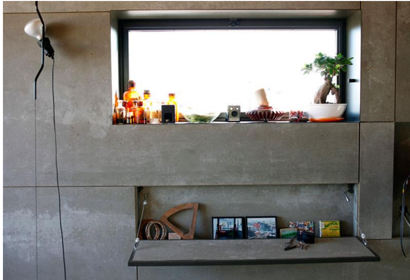
Ilustración 19. LEGO apartment, por Barbara Apolloni. Principio de despliegue a partir de un pivote para un escritorio adosado al muro.
