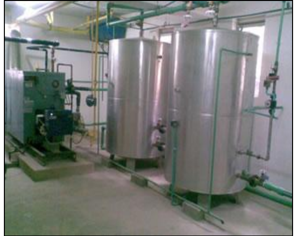
Foto No. 5 Mantenimiento de Caldera
