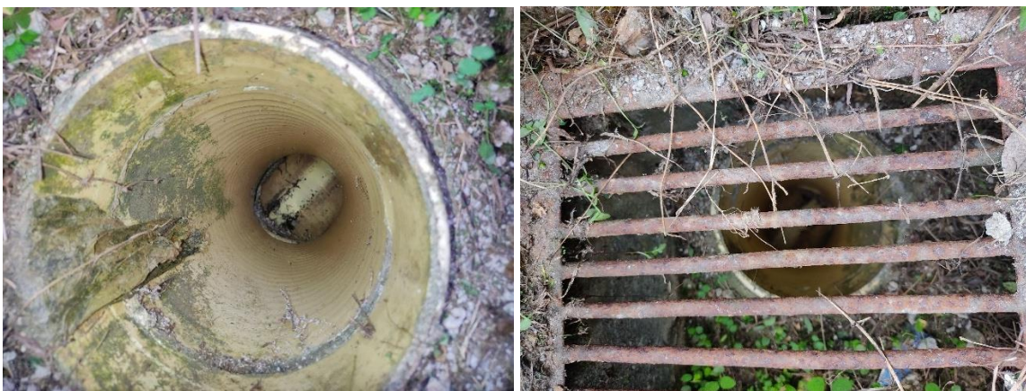
Figura 6: Sistema de ventilación donde se identifica la conexión del agua residual gris y aguas negras.
