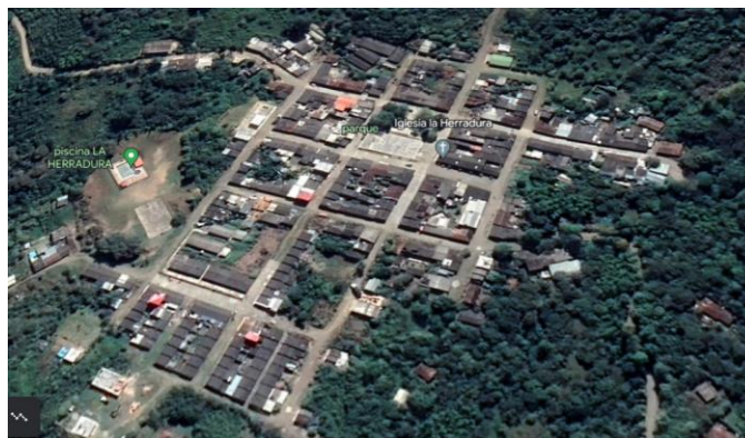
Figura 2: Vista satelital cabecera corregimental San Jorge La Herradura coordenadas 1^{\circ}52'13''N 76^{\circ}52'46''W y elevación de 1.715,51 m.
