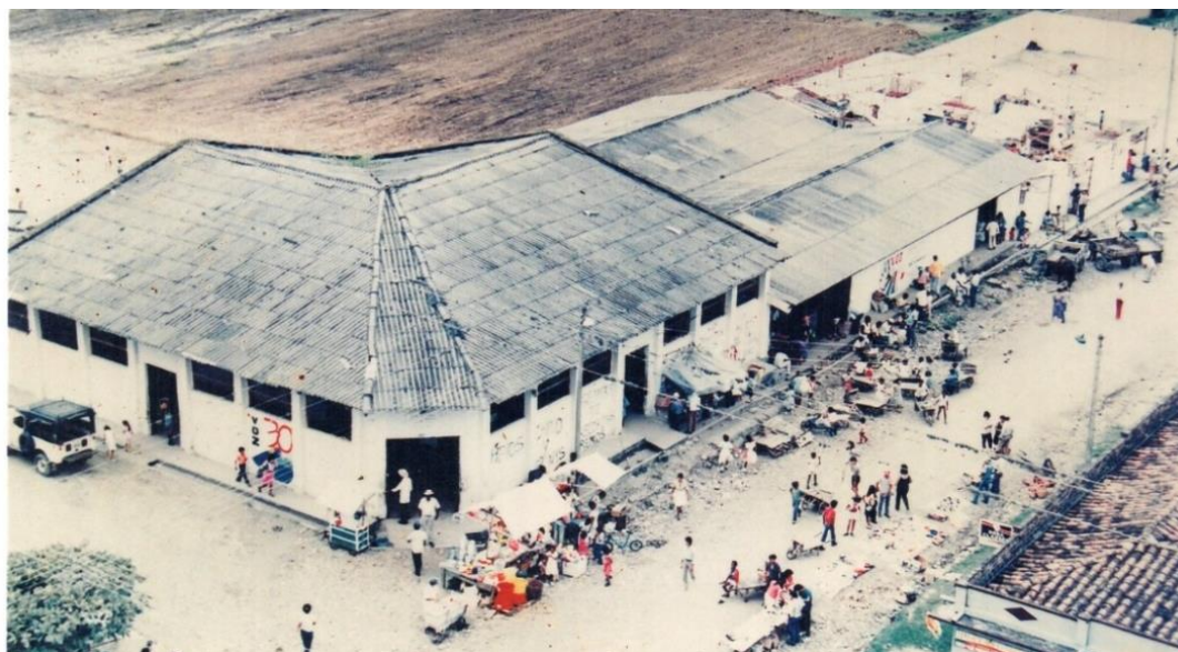
Fotografía 8. Galería municipal construcción del III nivel
