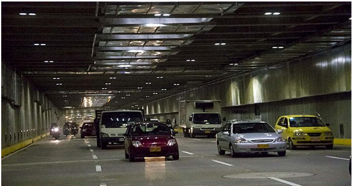
Foto 3.10, Interior del túnel de la Avenida Colombia [Fuente: El País]
