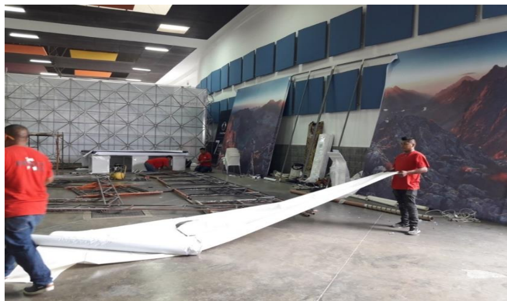
Figura 37. Instalación de impresión en pared de stand.
