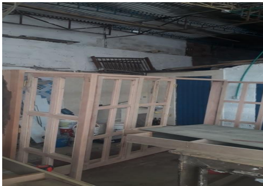
Figura 32. Construcción armazón de paredes.
