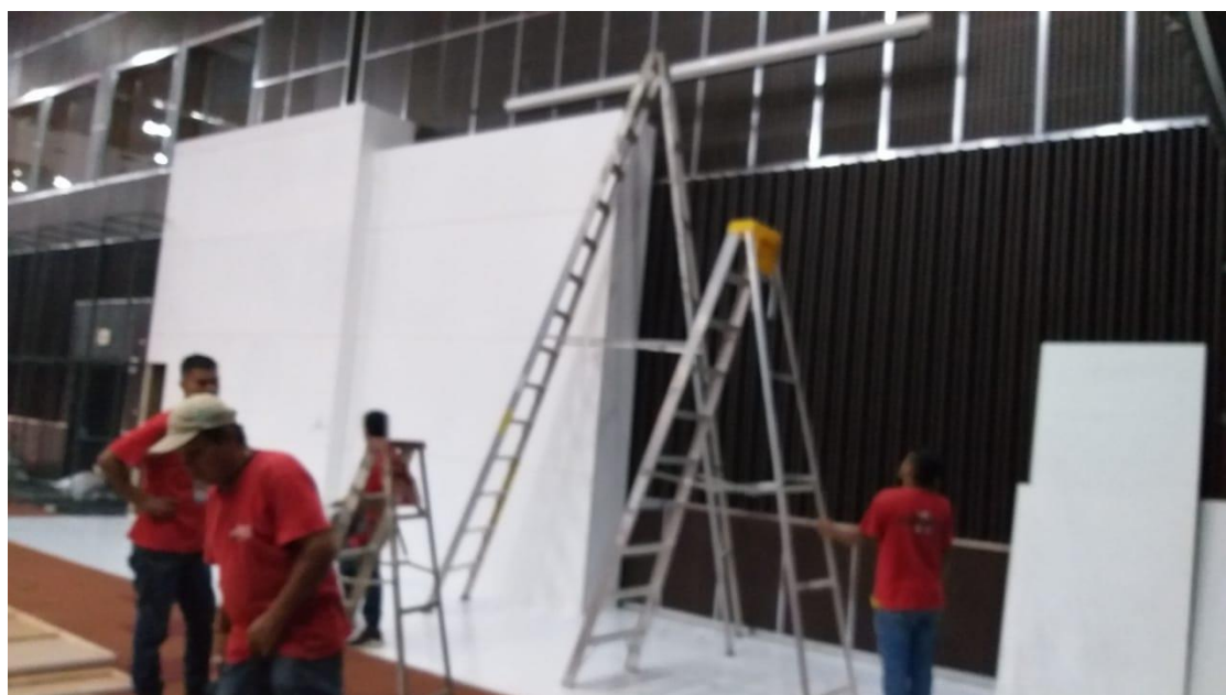
Figura 35. Terminación de paredes para Stand.
