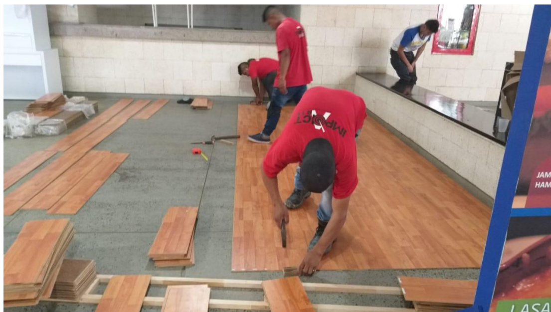
Figura 34. Instalación de piso en madera.
