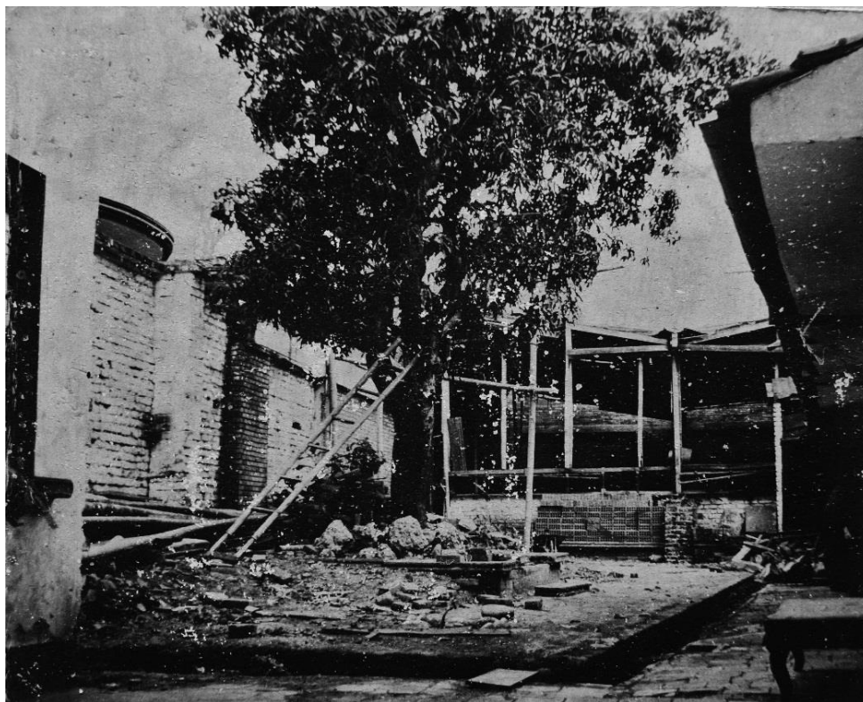
Figura 7: Proceso de construcción de la nueva sala del TEC
