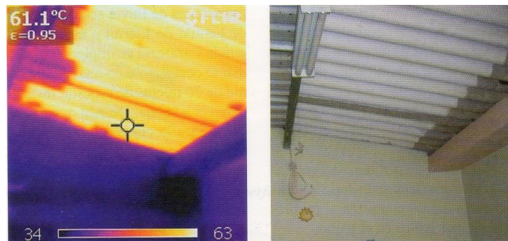
Figura 3. Termografía y fotografía fachada oeste Calicanto 1 junio 2:00pm. (Fuente: Confort Ambiental En la Vivienda de Interés Social en Cali)
