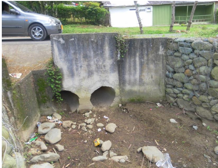
Gráfico 23. Canal de desagüe aguas lluvias.
