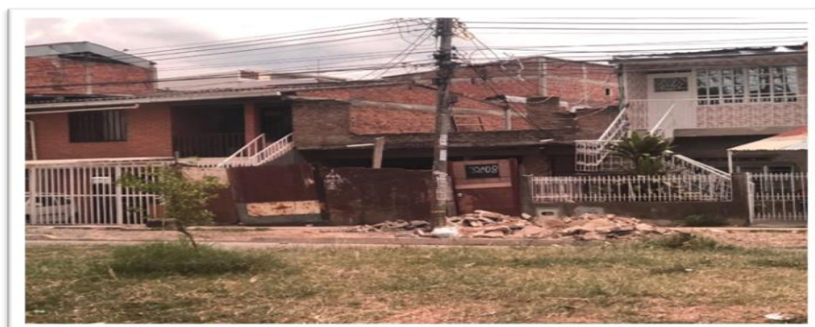
Imagen 6. Aceras ocupadas por escombros (Falta de educación ciudadana)
