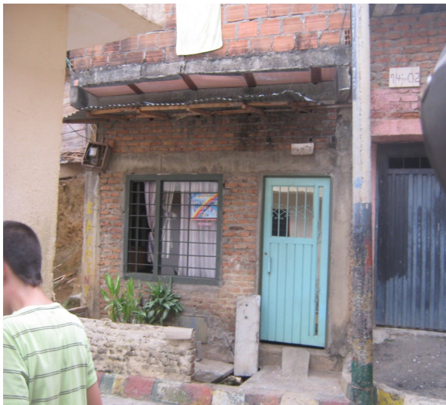
Foto No: 6 Tipo de uso: Casa lote unifamiliar B
