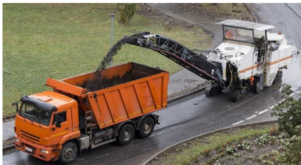
Ilustración 2. Fresado de Asfalto.
