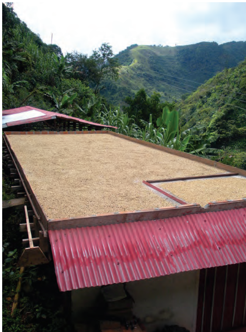
Municipio El Águila. Vereda Santa Helena, finca La Cascada. Foto: CITCE
