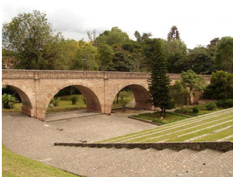
Imagen 2 Puente del Humilladero
