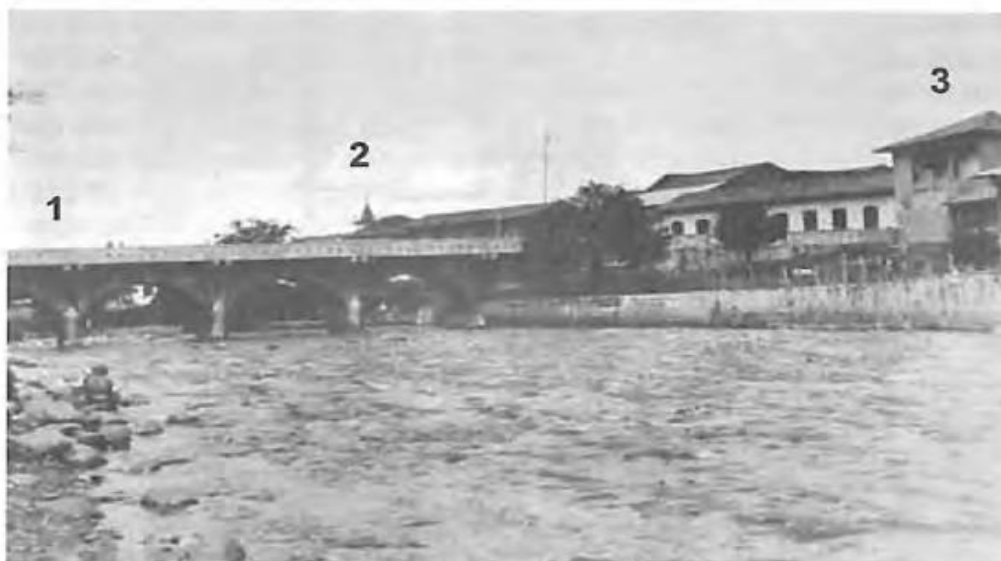
Figura 60. A la izquierda el puente Ortiz con las barandas y las vigas de ferrocemento dispuestas en 1918 (1); atrás, la primigenia capilla de La Ermita (2) y la casa Bosh (3) (ca. 1920).
