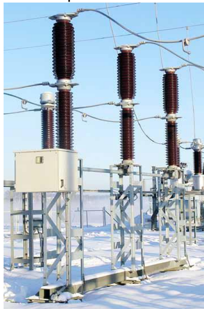
Figura 5. Interruptor en SF6 de tanque vivo.
