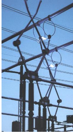
Figura 7. Seccionador tipo pantógrafo.
