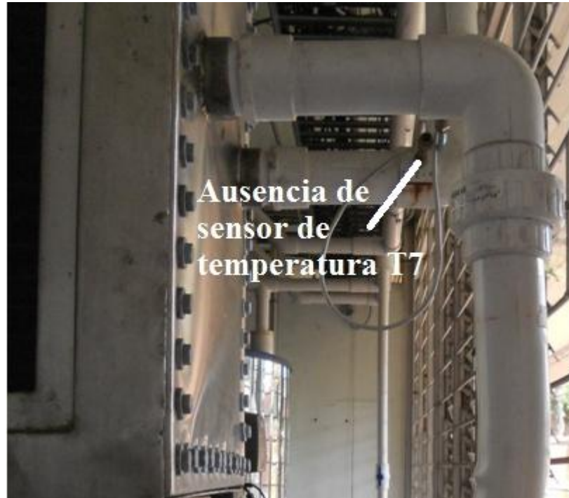
Foto 4. Ausencia de sensor de temperatura T7.
