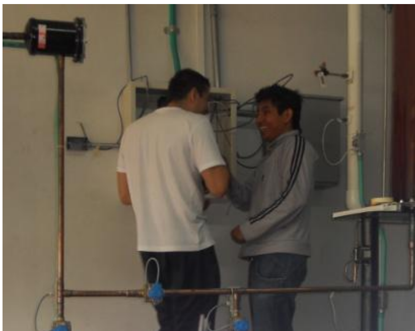
Foto 8. Enrutamiento programado de los sensores, transductores y válvulas en el Control.
