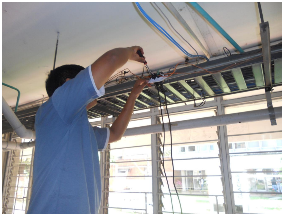
Foto 9. Instalación toma corriente 110v para el computador.
