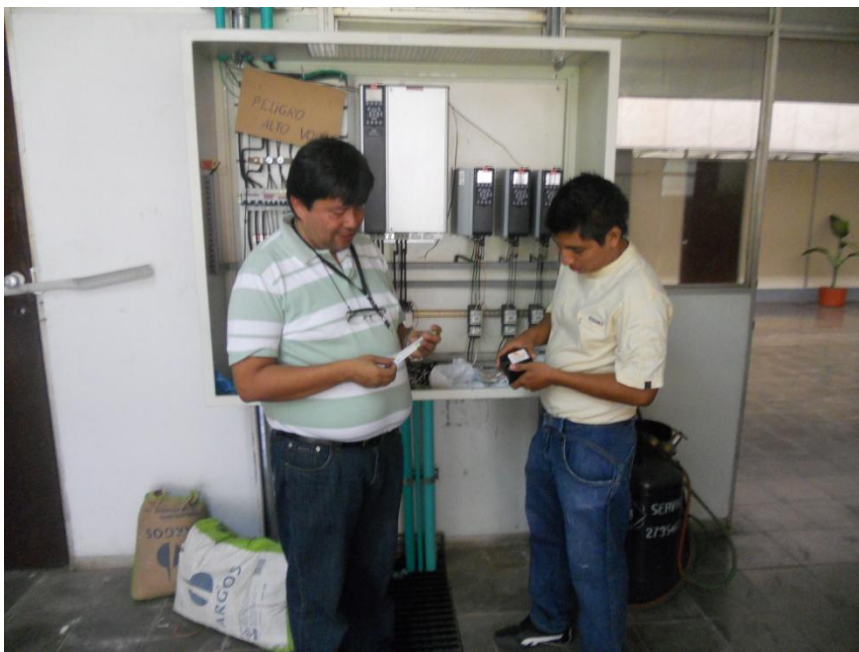
Foto 11. Recibimiento cable y transformador solicitado.
