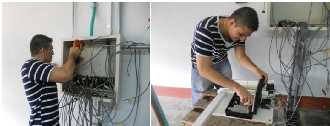
Foto 12. Reubicación tablero de control.
