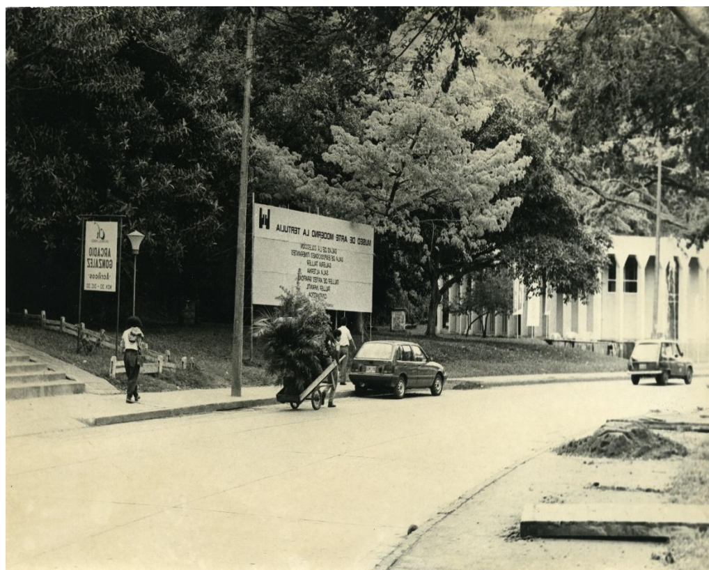
Figura 21. Exteriores del Museo La Tertulia. Fuente: Archivo del Patrimonio Fotográfico y Fílmico del Valle del Cauca (1989)
