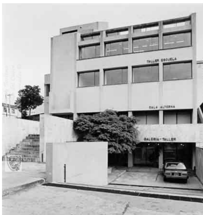
Figura 20. Edificio del taller, escuela de grabado, salas de exposición y apartamentos. Fuente: Archivo del Patrimonio Fotográfico y Fílmico del Valle del Cauca (1975)
