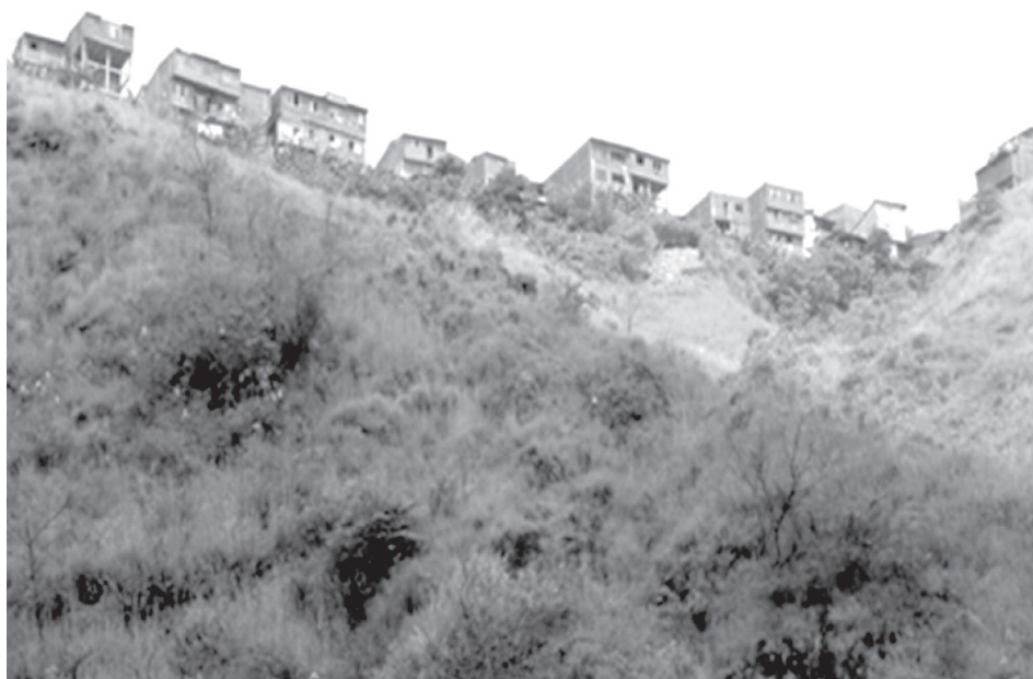
Presencia de fenómenos de remoción en masa.
