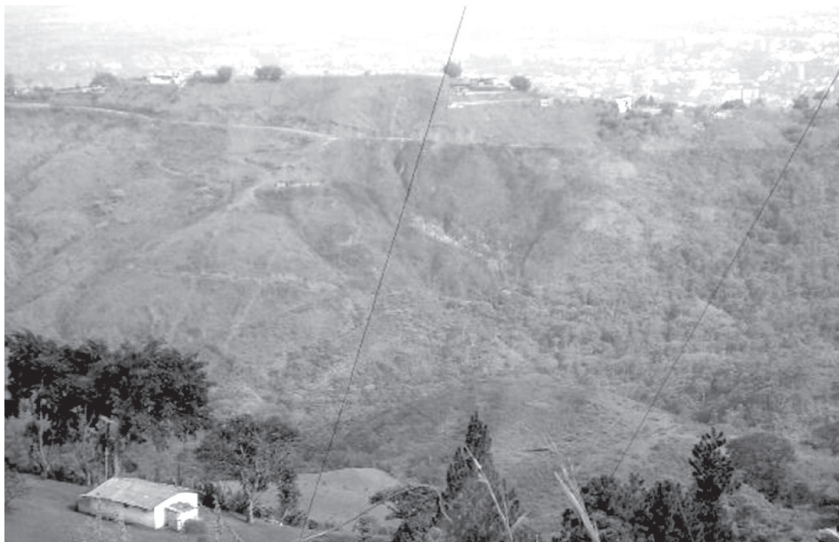
Procesos severos de erosión.
