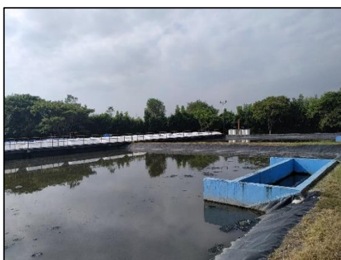
Figura 14. Laguna anaerobia de alta tasa
