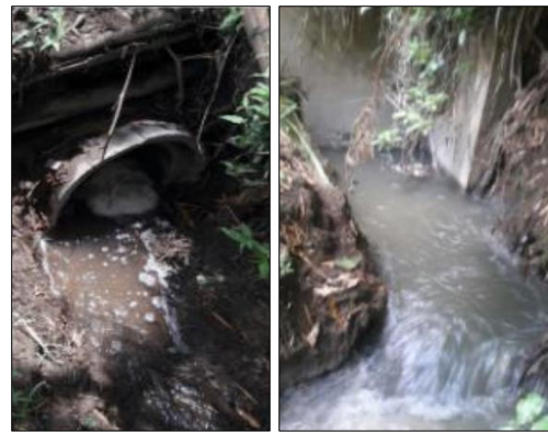
Figura 17. Vertimiento Río Sabaletas
