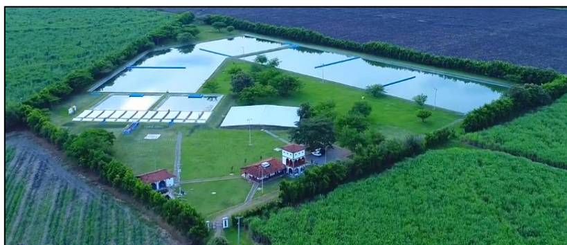
Figura 5. Fotografía aérea de la PTAR El Cerrito, Valle del Cauca
