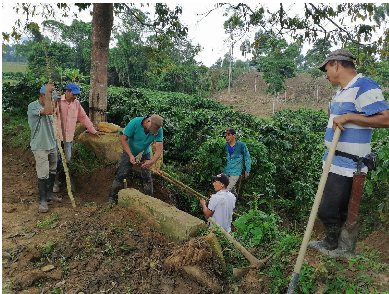
Ilustración 15 Minga para arreglar alcantarilla, JAC vereda Marticas Fuente: Manuel Alejandro Moreno
