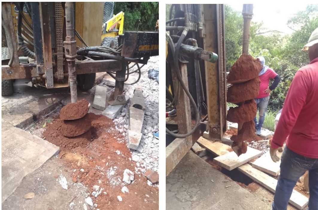
Figura 27. Registro fotográfico. Verificación de información en la parte alta del talud.
