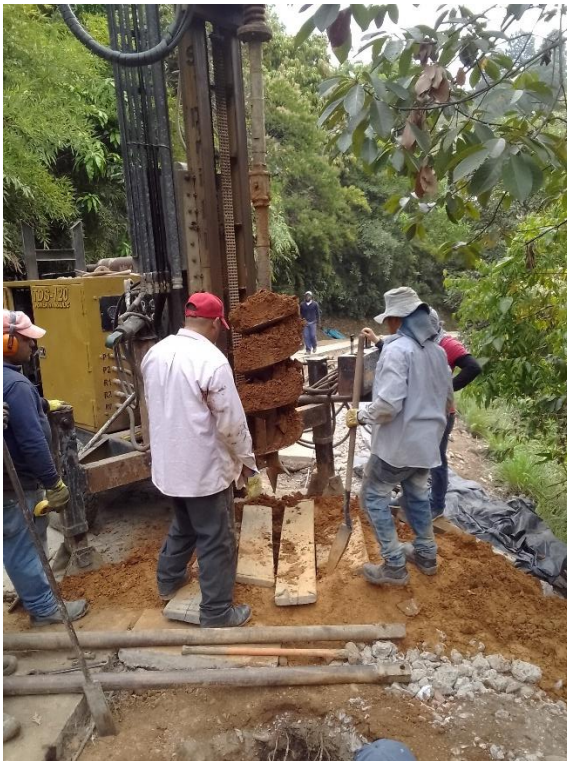
Verificación estratigrafía zona corona de talud. Fuente: Diaz (2022)
