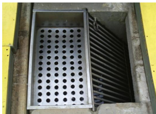
Fotografía 6. Canal de rejilla
