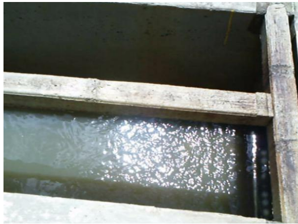
Fotografía 7. Desarenador
