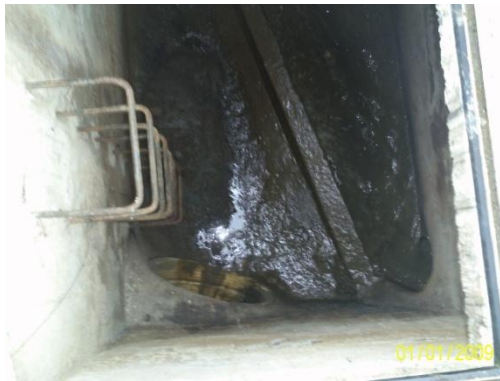
Fotografía 5. Estructura de separación.
