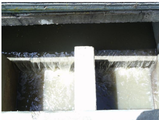
Fotografía 8. Caja de distribución de caudales
