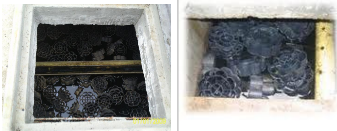
Fotografía 9. Filtro anaerobio y medio filtrante plástico
