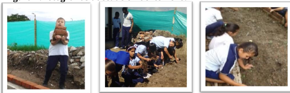
Figura 2. Fotografías adecuación del terreno.
