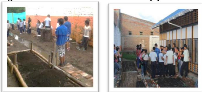
Figura 18. Encerramiento en madera y posteriormente en ladrillo.
