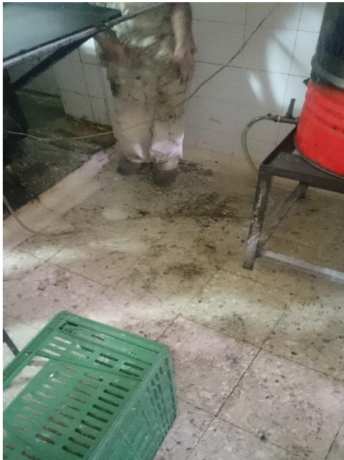
Ilustración 8 conexiones de combustibles inadecuadas
