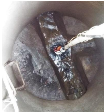
Figura 7. Vista interior de la cámara de inspección
